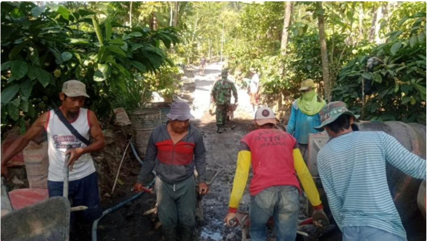
Warga Desa Tempur bergotong-royong pengecoran jalan menuju candi angin
