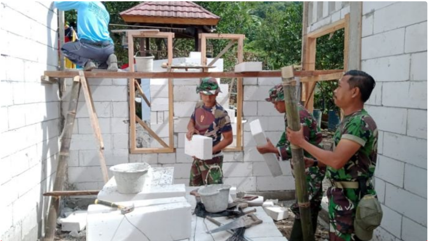
Anggota satgas TMMD Sengkuyung Tahap II dengan bergotong royong pemasangan herbel
